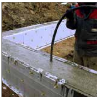
Вибрация бетона с помощью глубинного вибратора.
