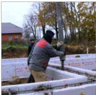
Подача бетона в опалубку при помощи бетононасоса.
